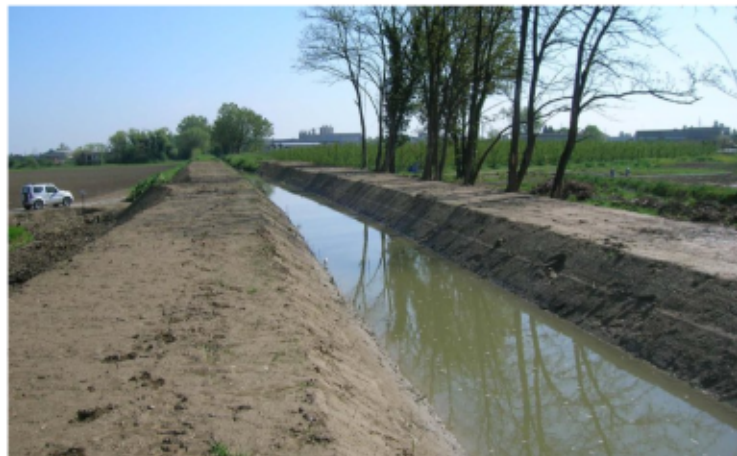
Gli argini risagomati del Canale dei Mulini
